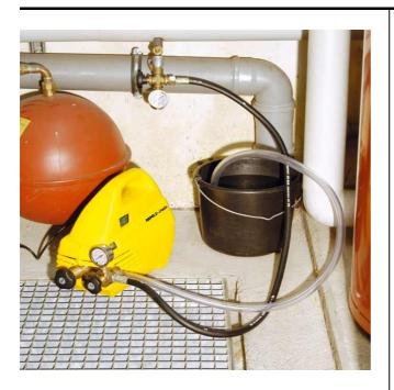
Pompe d'épreuve électrique, puissante, pour test de pression et d'étanchéité de système de tuyauteries et réservoirs. Idéal également pour remplir des installations solaires.
